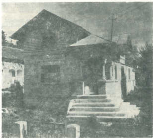
Casă-vilă construită la Vulcana Băi, după 23 August 1944.
